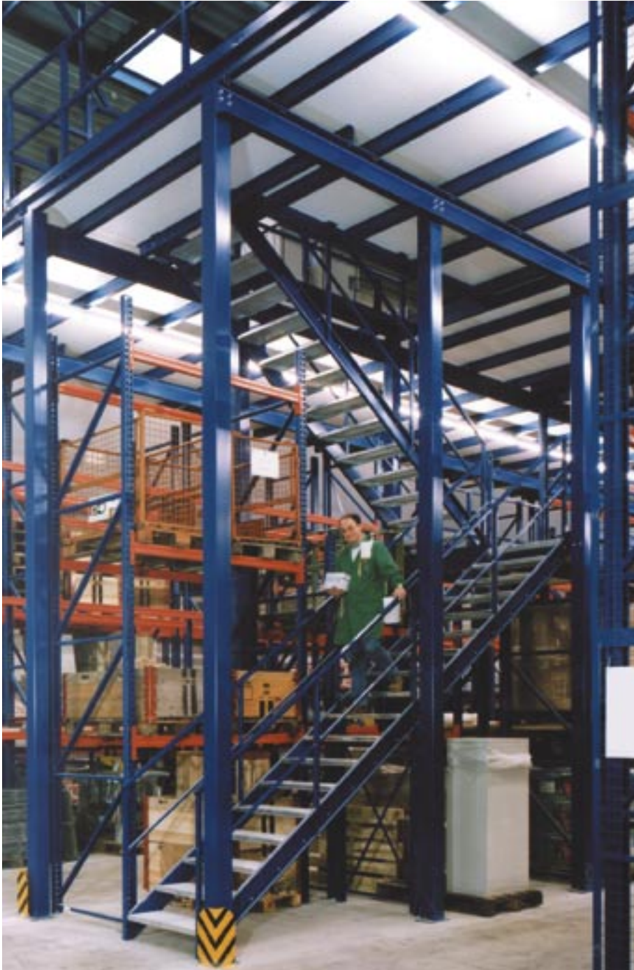
Palettenregalanlage mit Stahlbaubühne überbaut
